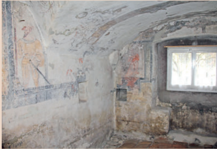
Gewölbekeller, Secco-Malereien 16. Jahrhundert
